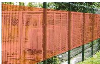
Détection espace étroit dans une zone stérile
